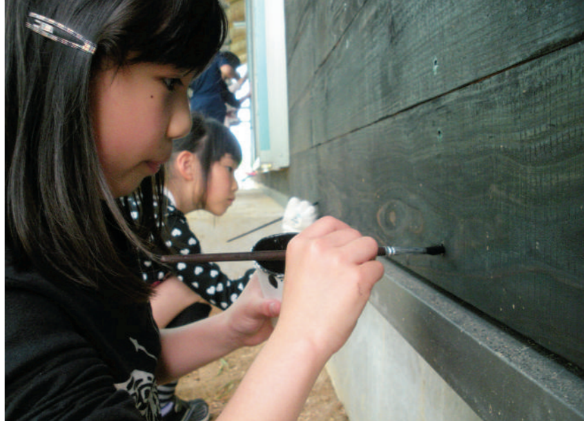
上/住民が提供した杉材を、住民みずからが焼杉加工し外壁としている。ビスの頭に、目立たないように子どもたちが塗料で黒く塗る仕上げ作業。左下/前浜マリセンターの上棟式でのお祝いの「ぐず餅撒き」。これに使われたモチ米のほとんどは、愛知県豊橋市立大崎小学校の子どもたちが支援してくれたもの。交流は今も続いている。左下/上棟式で餅拾いに興じる子どもたち。住民手作りの丸餅3000個が撒かれた。(写真提供:千葉一)
