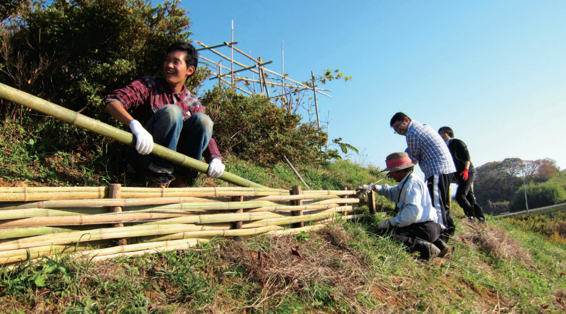
上/植樹のための基盤整備として、竹と杭で法面をテラス化する作業(写真提供:千葉一)左/ツバキの苗を育てるハウスの中で話す、「前浜おらほのとおき」代表の畠山幸治さん。
